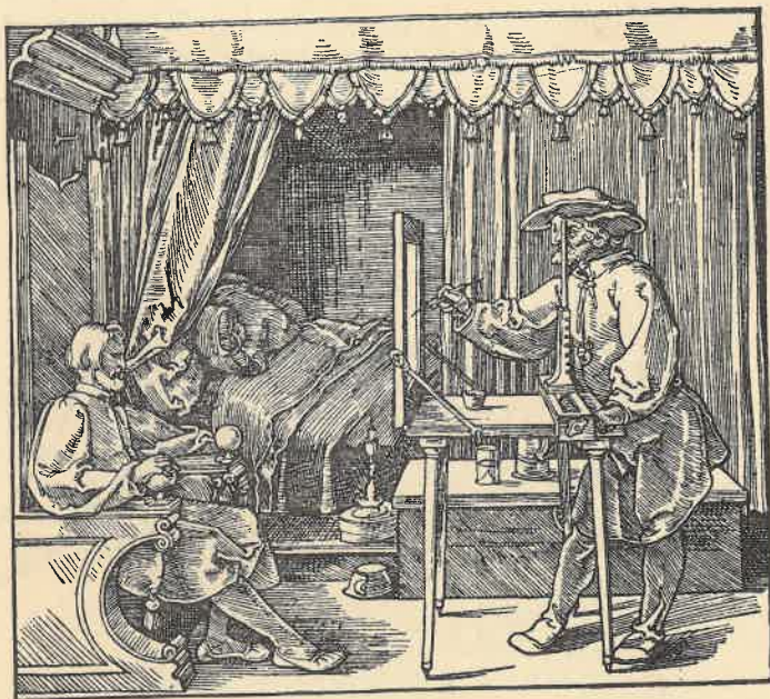
Fig. 2. — “El dibujante del hombre sentado”, famosa estampa de Alberto DURERO (1525). Mediante un aparato constituido por un ocular, desplazable en sentido vertical y horizontal, y una lámina de vidrio transparente, el dibujante ejecuta su bosquejo
