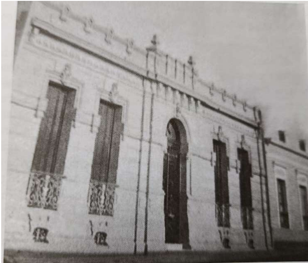
Figura 13. Aspecto general de la fachada del Palacio Penza.
