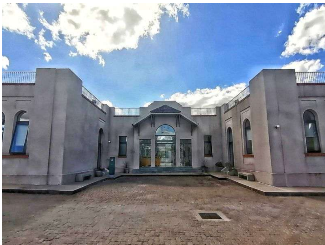
Figura 26. El antiguo edificio del Hospital de Durazno, inaugurado en 1927, reconvertido hoy como sede de la Zona Centro-Sur de la Universidad Tecnológica (UTEC).
