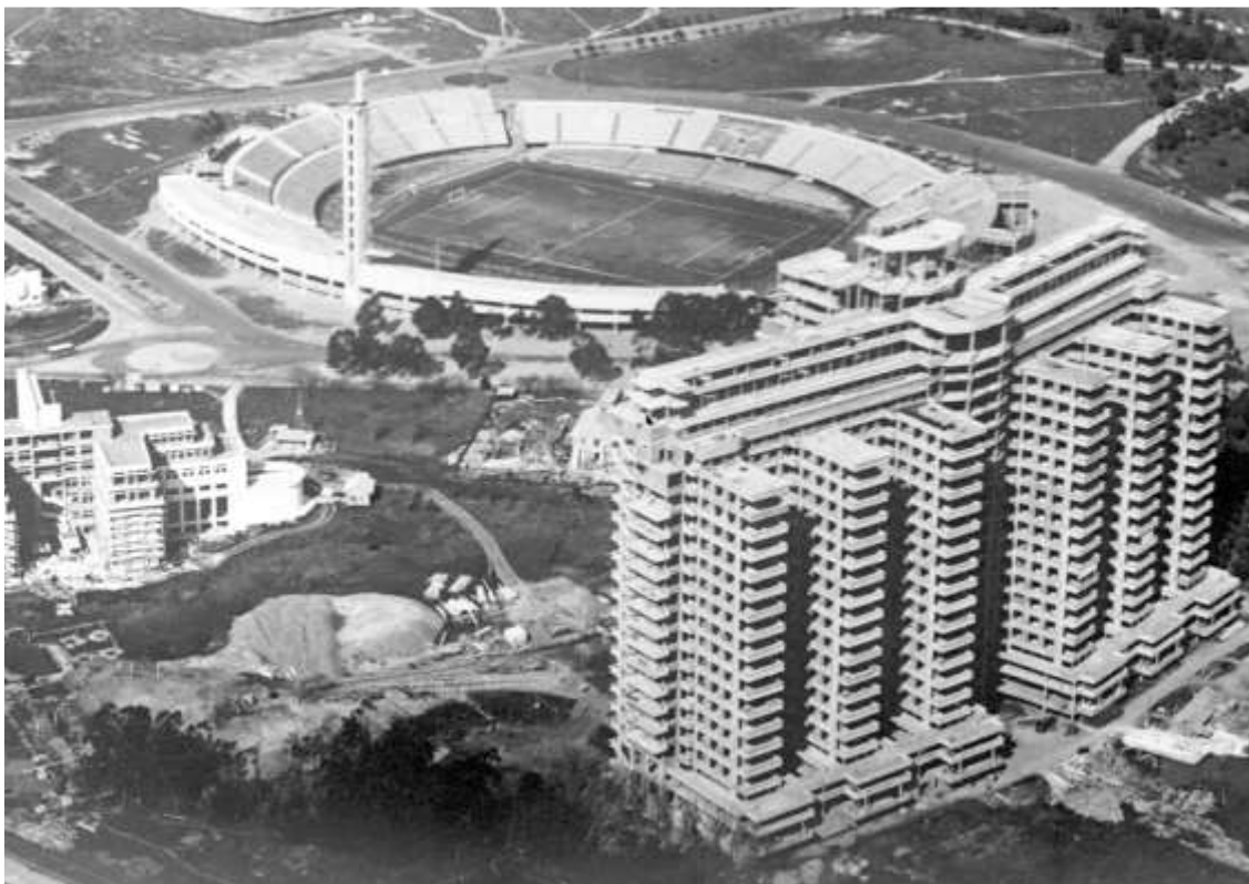
Figura 6. Hospital de Clínicas “Dr. Manuel Quintela” y Estadio Centenario. Detrás, el Instituto de Higiene “Dr. Arnoldo Berta”; también obra del Arq. Carlos A. Surraco.
