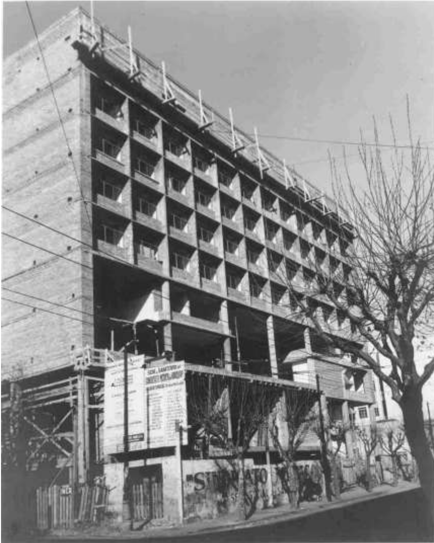
Figura 25. El avance de obra.
