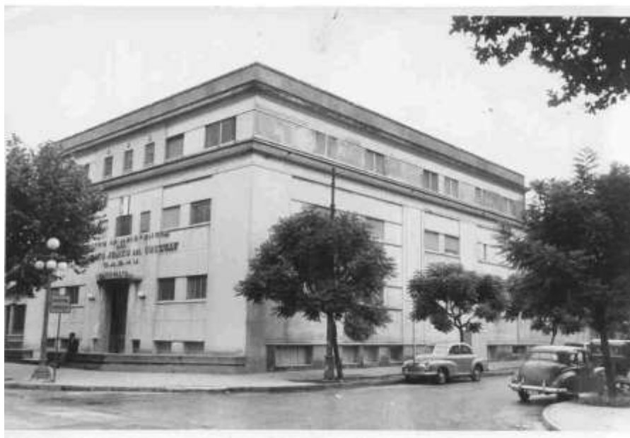
Figura 26. El Sanatorio Nro. 2 “Dr. Constancio E. Castells”, en Avda. 8 de Octubre y Agustín Abreu, mostrando la construcción primitiva y el primer agregado de una tercera planta.
